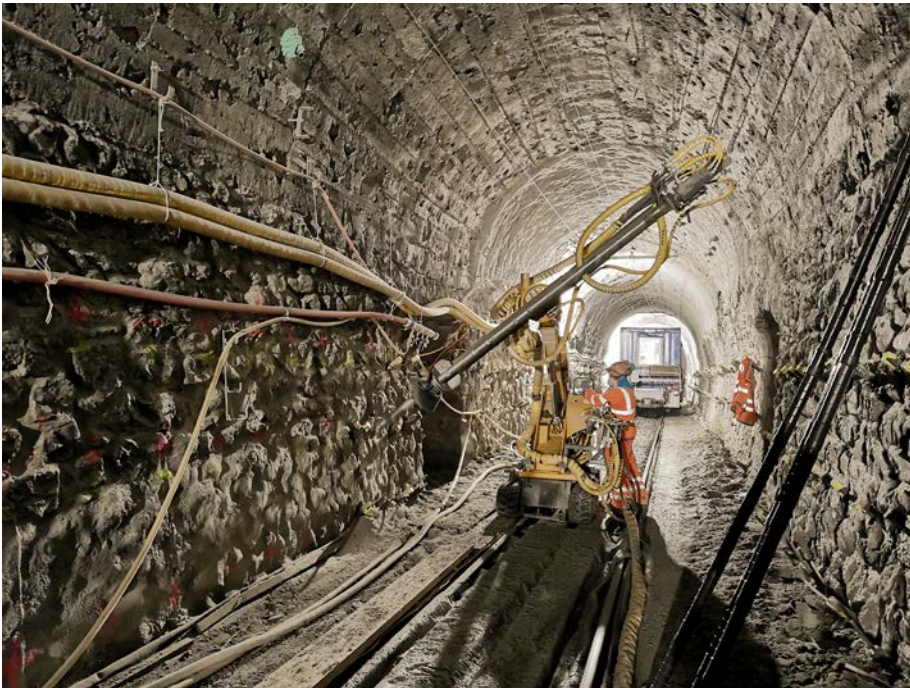
■ Bohren der Widerlagerinjektionen mit Bohrraube.
