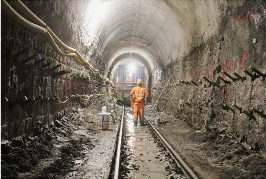
■ Injektionsarbeiten ab Bauzug.
